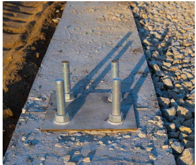
ZONA INDUSTRIAL DO CASALINHO, 2017 Lourosa, Portugal
